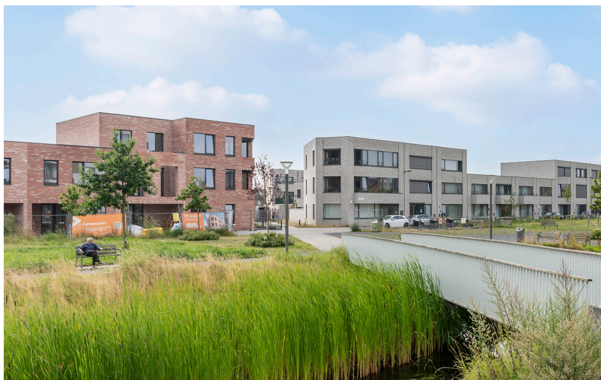
Deurne Eksterlaer _ Polo architecten, Veelaart Architecten Van Belle & Medina
